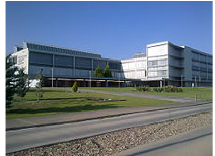
Edificio Agustín de Betancourt 2.000 m 2 aprox. 2.000 plazas de aparcamiento.
