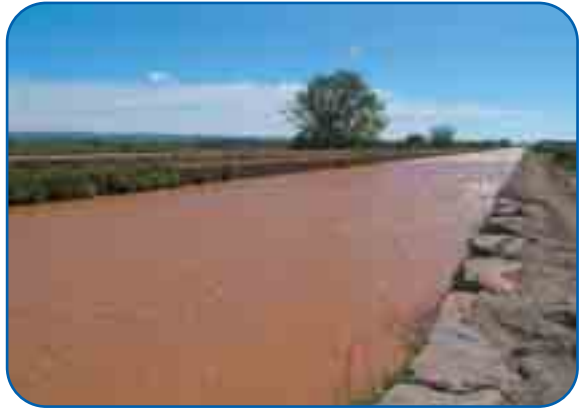
Canal Imperial de Aragón en las proximidades de su paso sobre el río Jalón
