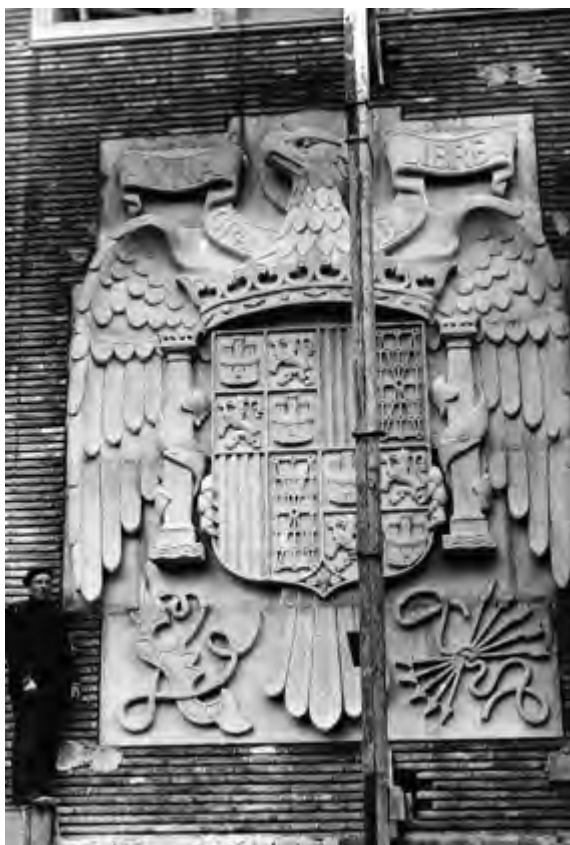
Fig. 13. Colocación del escudo sobre el balcón central de la fachada principal del edificio del Gobierno Civil, diciembre de 1952.
