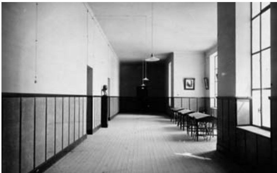
Fig. 13. Aspecto de la biblioteca instalada en la galería de las escuelas graduadas de Zuera (Zaragoza), 1930.
