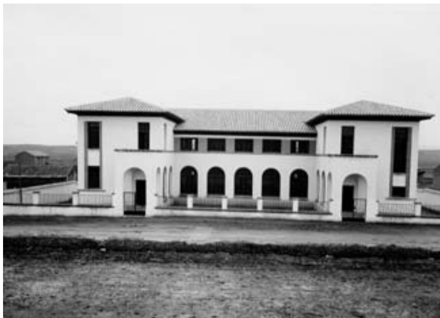
Fig. 7. Edificio para escuelas unitarias de niños y niñas en Lanaja (Huesca), construido por el arquitecto Regino Borobio, 1934.
