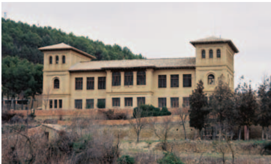
Fig. 11. Vista actual del edificio proyectado para escuelas graduadas en Uncastillo (Zaragoza), por el arquitecto Joaquín Muro en 1923.
