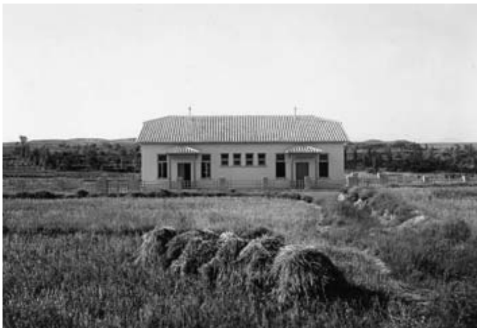
Fig. 1. Edificio de escuelas unitarias para niños y niñas en Huerto (Huesca), construido conforme al proyecto redactado por el arquitecto M. López Mora en octubre de 1928.
