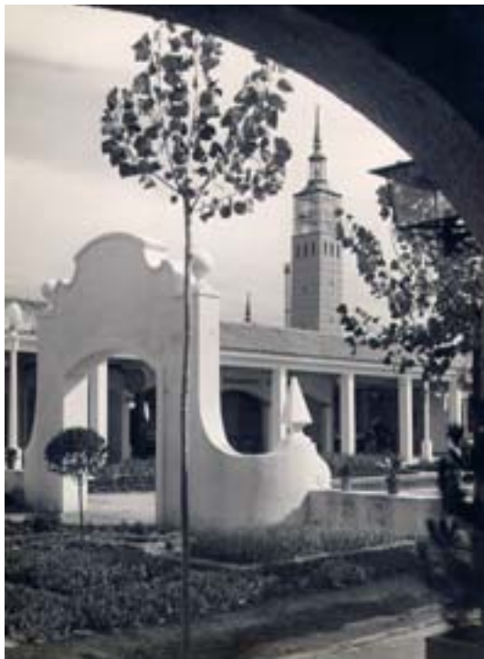
Figura 10. Vista parcial de la antigua Feria de Muestras de Zaragoza, 1944.
